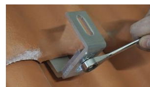
C. Drag åt med M10 flänsmutter 140622. Åtdragningsmoment 25-27 Nm
