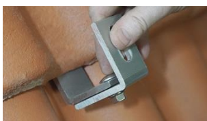
B. Placera L-vinkel under takkrok, med räfflade sidor mot varandra och justera till önskad höjd.
