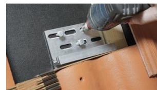
C. Förskruva grundplatta.
