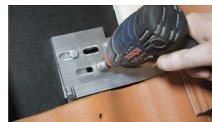
F. Drag åt grundplatta. Bekräfta avstånd mellan grundplatta och takpanna.
