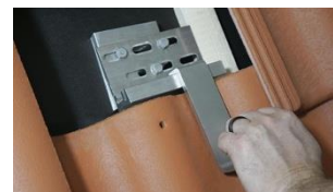
C. Tryck i takkrok för hand, du skall EJ slå eller använda våld.
