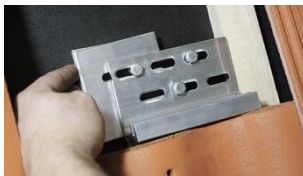
E. Shimsa grundplatta så den sticker upp några mm högre än underliggande takpannas dal.
