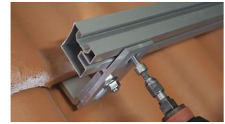
C. Drag åt skena med M8 insexskruv 140114. Åtdragningsmoment 8-10 Nm
