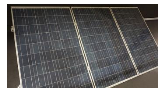
F. Avsluta panelrad med ändklämmor.
