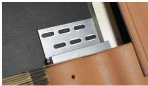
B. Placera grundplatta 120113 centrerat och cirka 3 mm fritt från underliggande takpannas dal.
