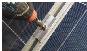
E. Skjut intill nästkommande solcellspanel och drag åt. Åtdragningsmoment 8-10 Nm
