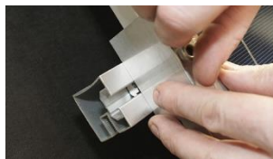
E. Gänga in ändklämma och insexskruv för hand, för att undvika korsgängning.
