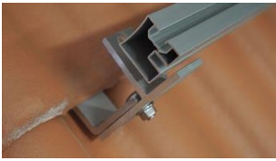
A. Placera skena 110112/110117 med räfflat spår mot T-vinkel.
