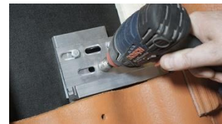
F. Drag åt grundplatta. Bekräfta avstånd mellan grundplatta och takpanna.
