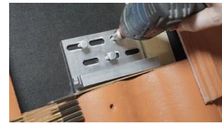
C. Förskruva grundplatta.
