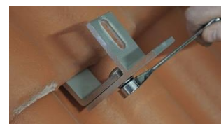
C. Drag åt med M10 flänsmutter 140622. Åtdragningsmoment 25-27 Nm
