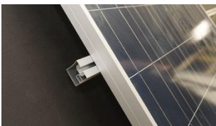
A. Placera solcellspanelen på skenor.
