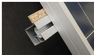
B. Skena behöver sticka ut minst 40 mm.
