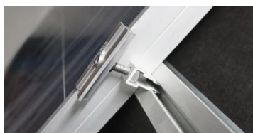
P. Skjut intill mittklämma mot solcellspanel.
