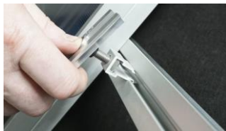
N. Placera mittklämmans clips i skena och tryck i för hand
