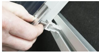
O. Du skall EJ slå eller använda våld för att montera mittklämma.
