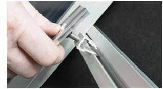
C. Du skall EJ slå eller använda våld för att montera mittklämma.
