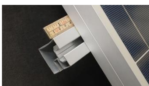
B. Skena behöver sticka ut minst 40 mm.
