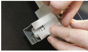
E. Gänga i ändklämma och insexskruv för hand, för att undvika korsgängning.
