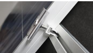
D. Skjut intill mittklämma mot solcellspanel.
