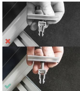
6A. Insexskruv på mittklämma får EJ vara för långt gängad genom clips.
