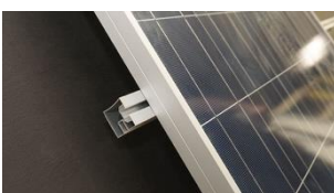
A. Placera solcellspanelen på skenor.
