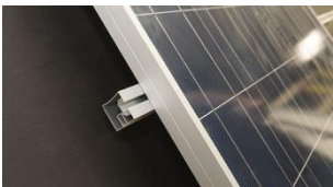
A. Placera solcellspanelen på skenor.
