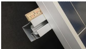
B. Skena behöver sticka ut minst 40 mm.
