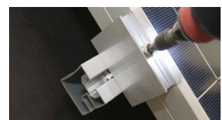
F. Skjut intill ändklämma mot solcellspanel och drag åt. Åtdragningsmoment 8-10 Nm
