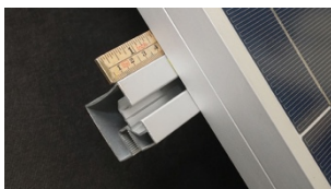
B. Skena behöver sticka ut minst 40 mm.
