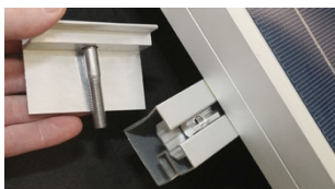
D. För i insexskruv i ändklämma.
