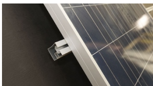
A. Placera solcellspanelen på skenor.
