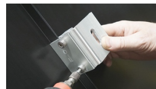
C. Flytta klämma till önskad position på fals och drag åt. Max åtdragningsmoment 17 Nm
