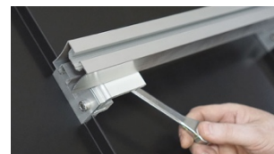
C. Drag åt skena med M10 flänsnutt 140622. Max åtdragningsmoment 33 Nm
