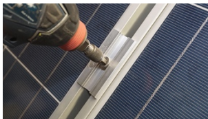
E. Skjut intill nästkommande solcellspanel och drag åt. Max åtdragningsmoment 17 Nm
