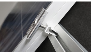
D. Skjut intill mittklämma mot solcellspanel.
