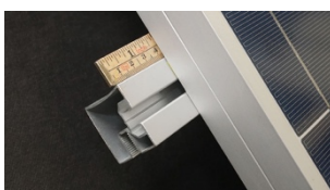
B. Skena behöver sticka ut minst 40 mm.
