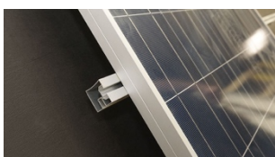
A. Placera solcellspanelen på skenor.
