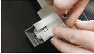
E. Gänga i ändklämma och insexskruv för hand, för att undvika korsgångning.
